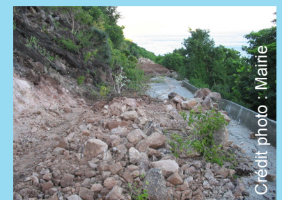
11 : Eboulement et chutes de gros blocs obstruant la route (RD213)
