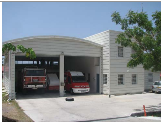
Photo. 2 : Nouveau centre de secours de Terre-de-Bas.
