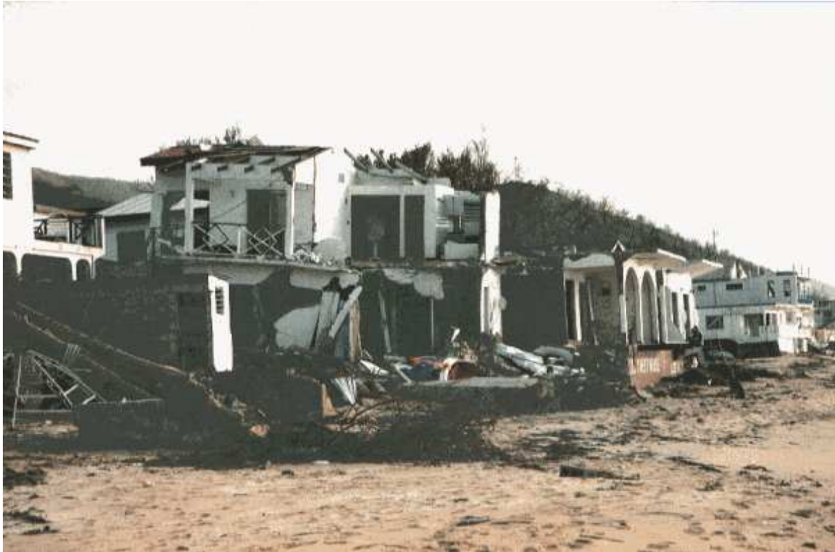
Photo 10 : Exemple de désordres observés après déferlement des houles cycloniques
