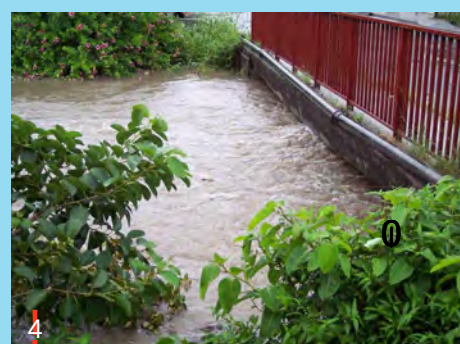
Ravine Bambara : mise en charge du pont RN9
