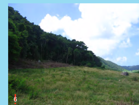
6 Gros blocs éboulés
