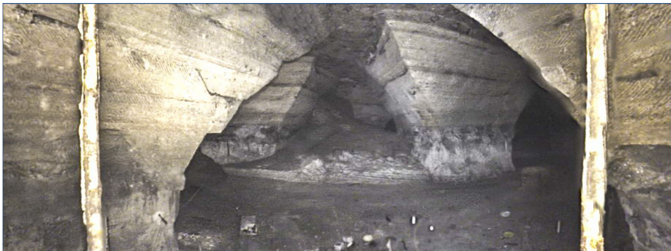
Figure n°18 : Photo de la carrière à proximité de la route de Montigny (recouvrement 30m ; hauteur de vides 11m)- ( Source : IGC)
