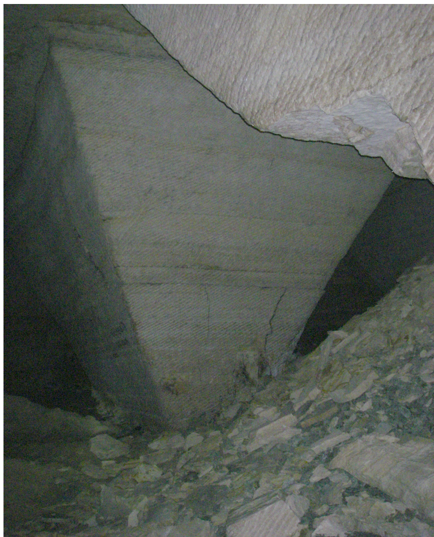
Figure n°19 : Photo de la carrière (recouvrement 30m; hauteur de vide 6m)-(Source :IGC)
