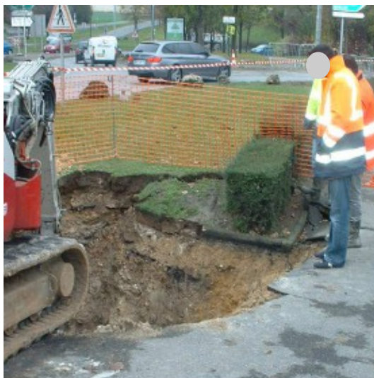
Figure n°14: Effondrements en bordure de la RD105 - Commune de Villeparisis (photographies source CETE IF)
