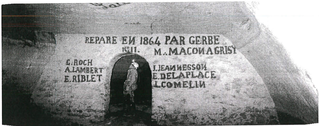
Vue d'une galerie de forme trapézoïdale confortée en 1864 (levée de terre au centre de la galerie).
