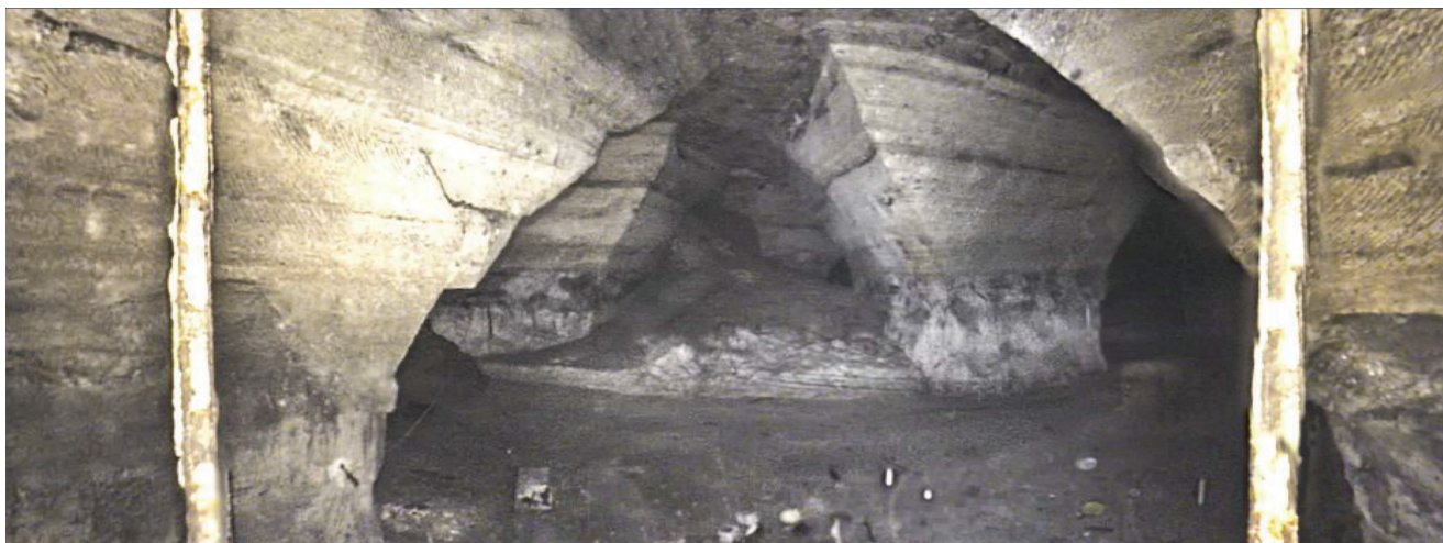
Exemple d'une carrière souterraine de 1ère Masse de gypse (Corneilles-en-Parisis)
