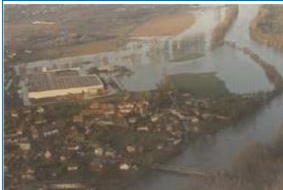
Crue de la Vienne de 1994 à Cenon-sur-Vienne, à la confluence du Clain et de la Vienne (SLGRI TRI de Châtelleraut, 2016)
