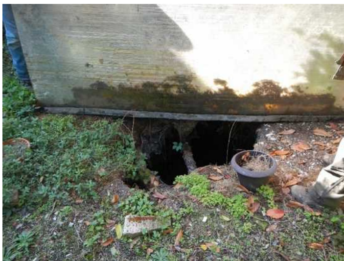
Figure 10 : Fontis dans la propriété de Mme Merle (source : Ineris)
