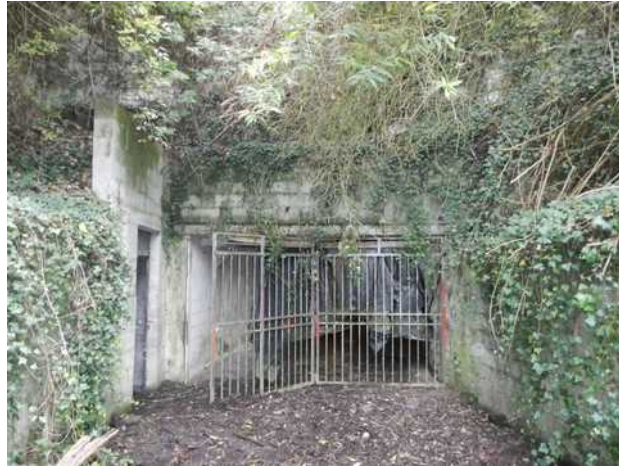
Figure 5 : Entrée en cavage (source : Ineris)
