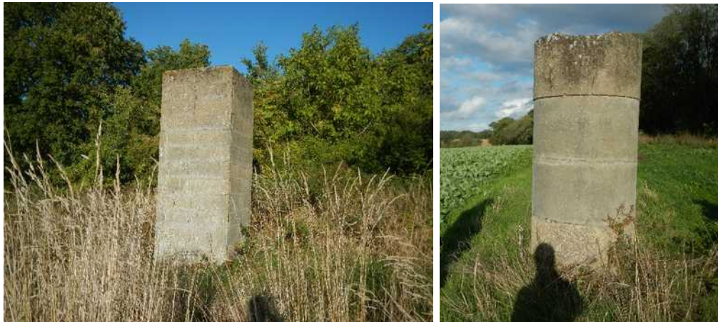
Figure 7 : Photos de cheminées d'aération (source : Ineris)
