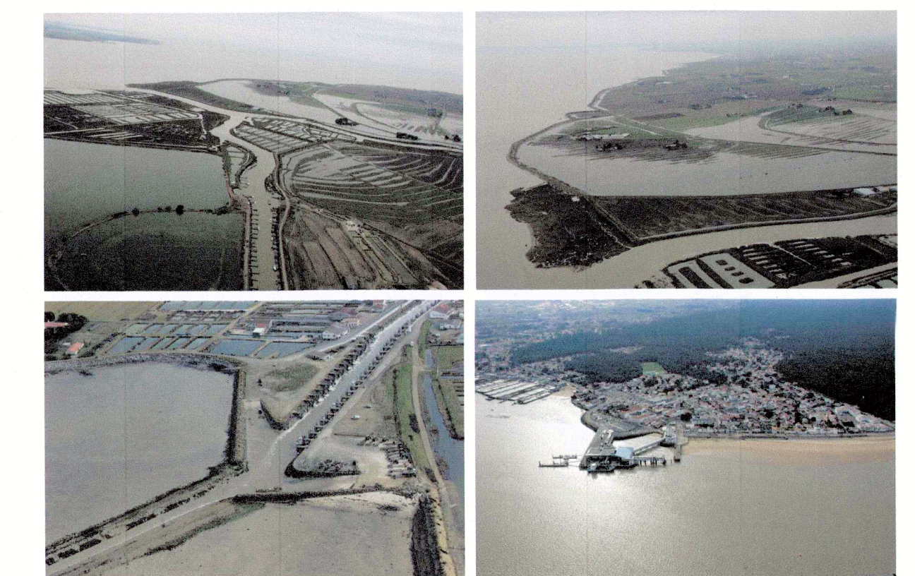
Baie de Bourgneuf après le passage de Xynthia
