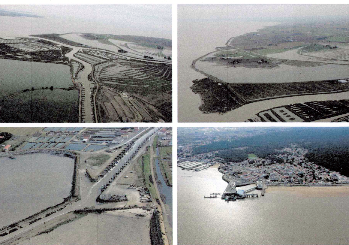
Baie de Bourgneuf après le passage de Xynthia
