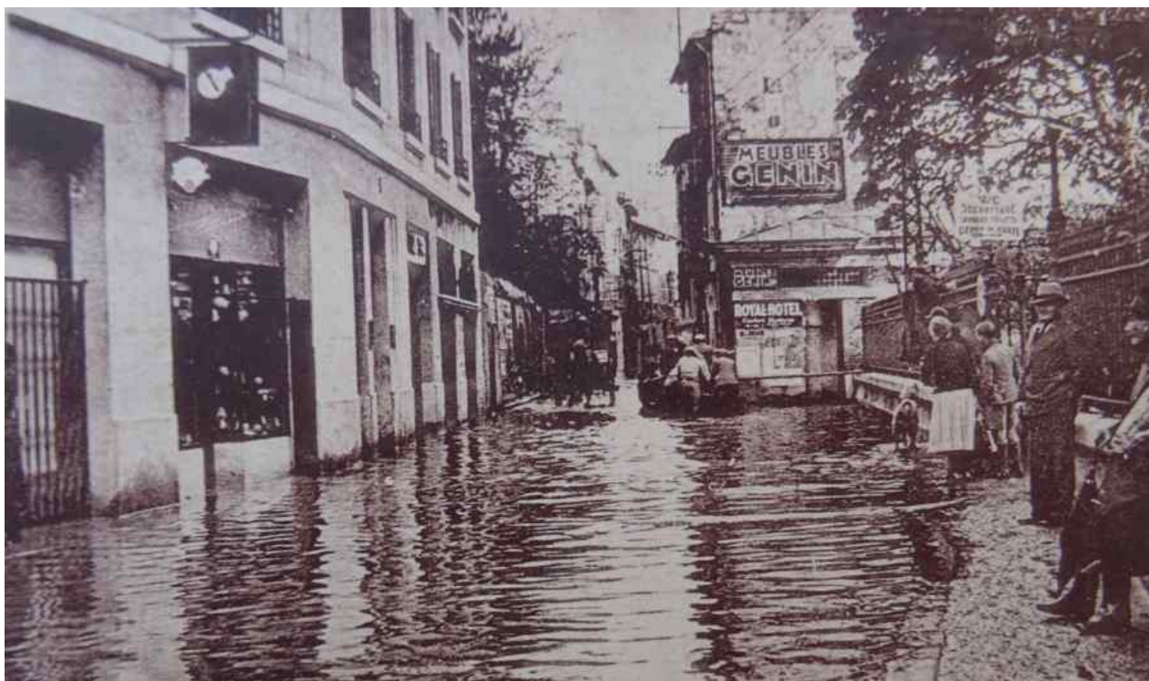
Crue de novembre 1935 : Avignon - rue Henri Fabre
