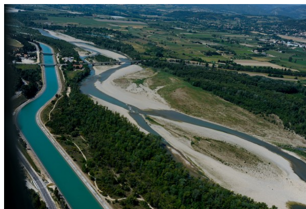
Le canal EDF et le lit de la Durance
