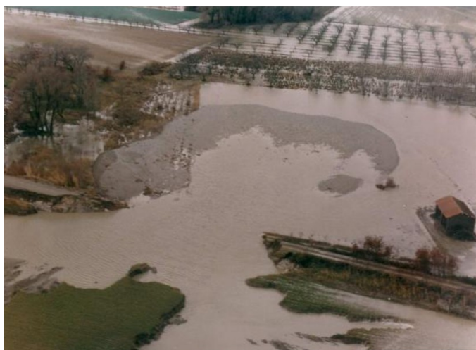
Rupture de l'Epi de Basse Plaine à la Roque d'Antheron, crue de la Durance de janvier 1994
