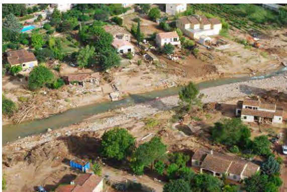
Photos 34 : Amont du Pont de la RD10 – Florièvre à Taradeau - Post crue
