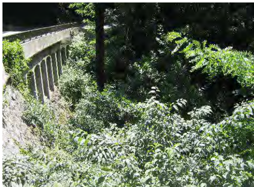
Photos 99 : Vallon des Tours en amont de la route de Figanières
