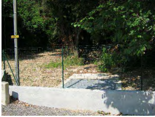
Photos 95 : Vallon de la Riaille – engouffrement actuel sous le Bvd Collomp (Juin 2011)
