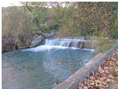
Photos 94 : Seuil de prise d'eau sur la Nartuby en aval du confluent avec la Foux
