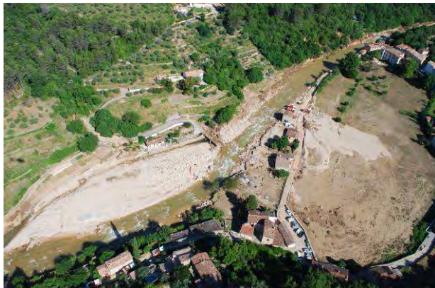
Photos 68 : La Nartuby à Rebouillon – Post Crue
