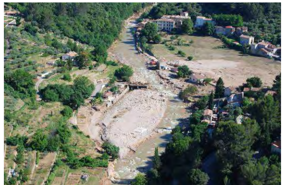
Photos 67 : La Nartuby à Rebouillon – Post Crue
