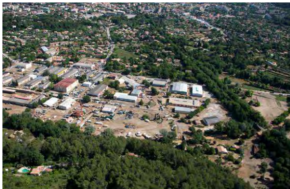
Photos 88 : Vues générales post crue – du pont de Lorgues à l'ancienne - Voie ferrée
