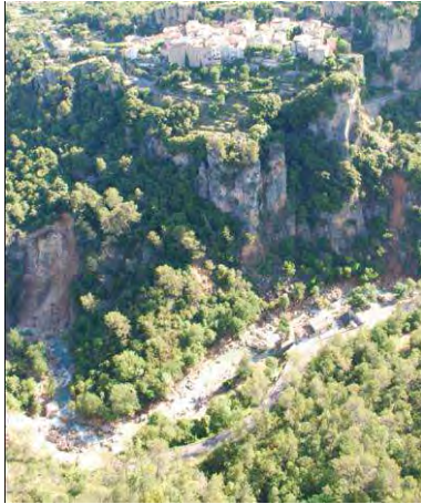
Photos 62 : La Nartuby dans les Gorges – Post crue
