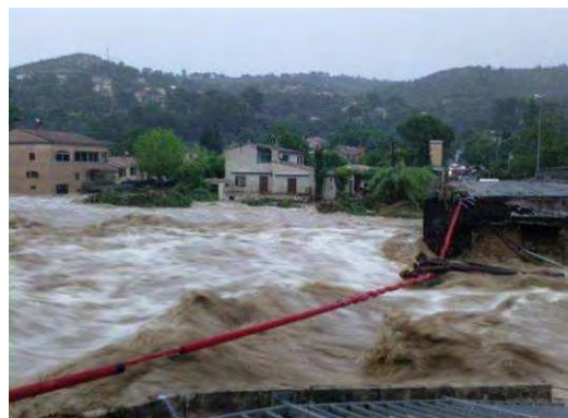
Photos 35 : La Florièvre à Taradeau : Pont de la RD 10 emporté
