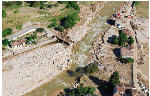
Photos 69 : La Nartuby à Rebouillon – Post Crue
