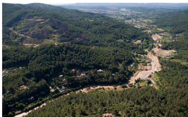
Photos 71 : La Nartuby secteur Granegone Vallon de Tunis – Post Crue
