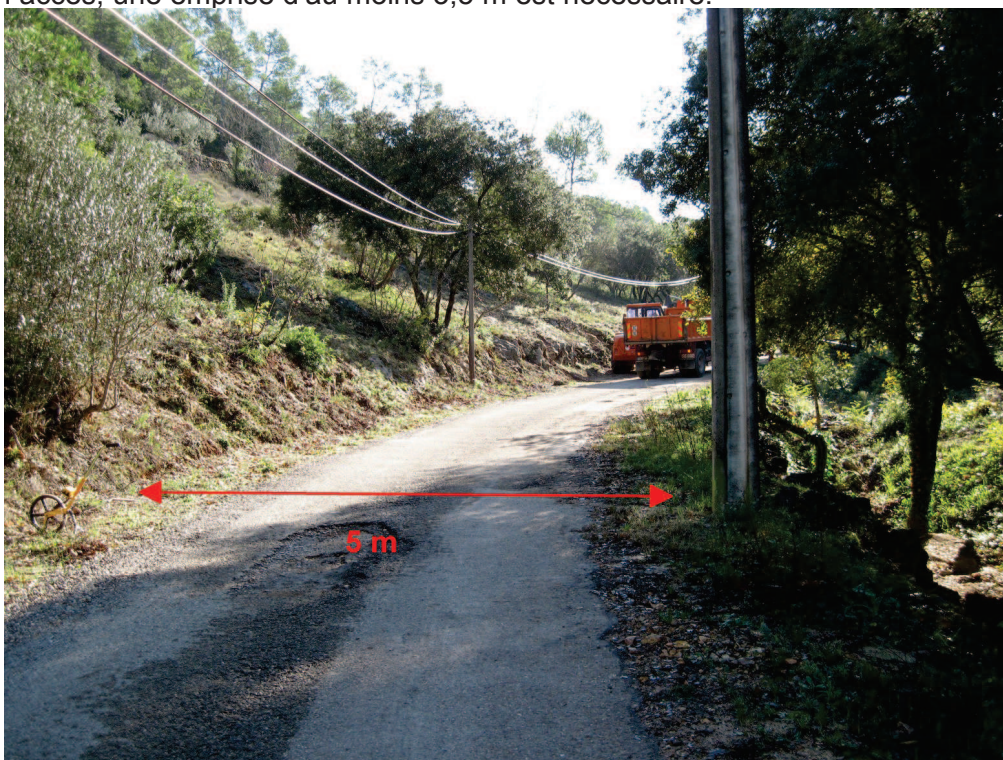
Travaux réalisés pour élargir le chemin de la Fouan de l'Olivier à 5 m (quartier de Chaume)
