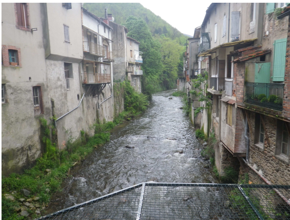
L'Arnette à l'amont de la section busée (source : AGERIN sas)
