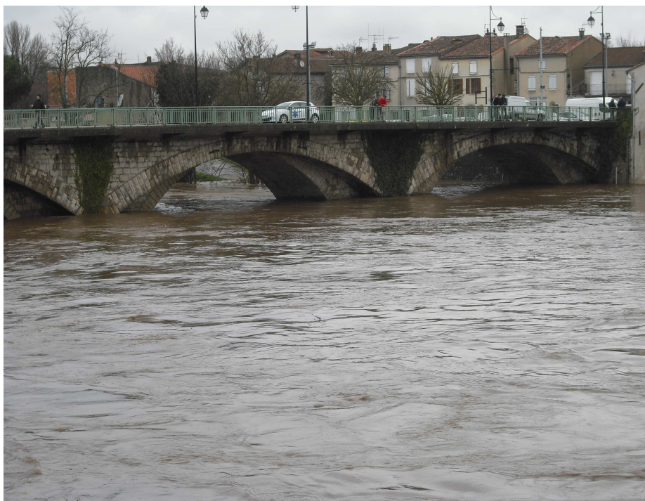
Le Thoré au pont Guillemet à Labruguière lors de la crue du 16 mars 2011 (source : Mairie de Labruguière)
