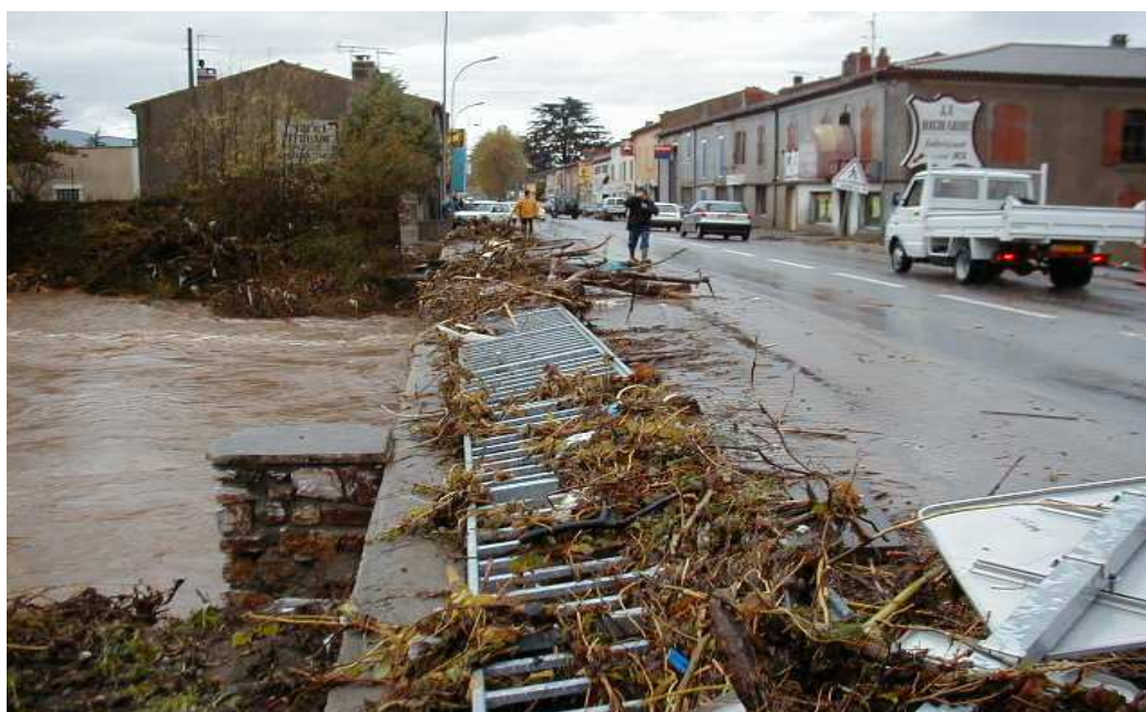
Commune de Mazamet : embâcle au pont de la Richarde (N112) en 1999 (Source : DDT81)
