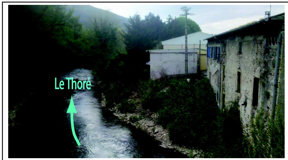
Vue sur le Thoré depuis le pont de la D53 et sur les bâtiments impactés par les crues à Saint-Amans-Valtoret (Source : AGERIN sas)
