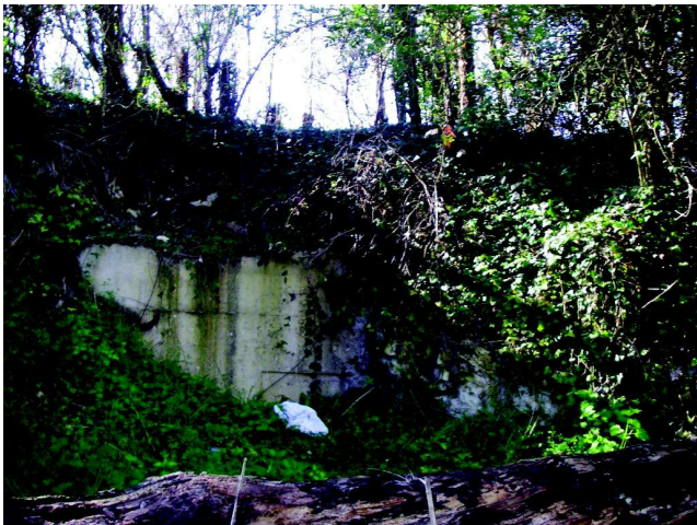
Ancienne entrée en cavage murée (Cliché IGC mars 2019)
