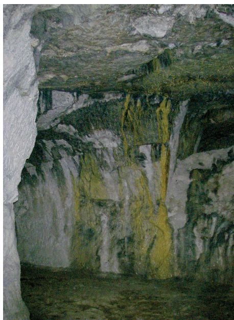
photo 3: Exemple de craie altérée par les infiltrations en pied de versant (carrière Delaizement-Terrel des Chênes_Port-Marly)
