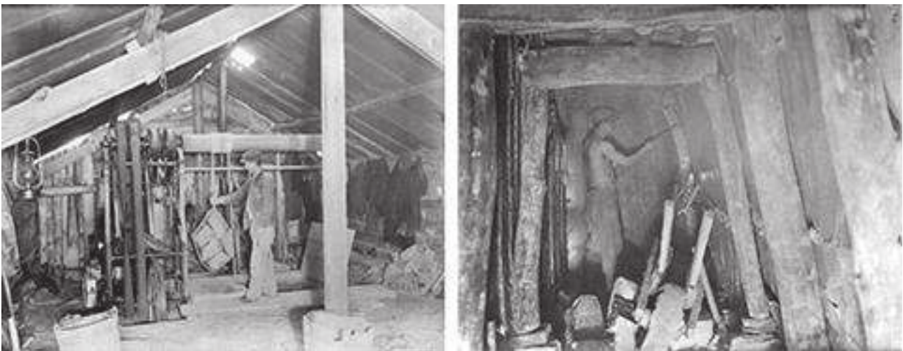
photo 7: Puits et extraction souterraine d'argile plastique – (source : IGC Paris)
