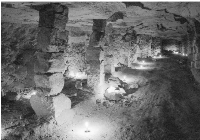
photo 3: Galerie avec piliers à bras
