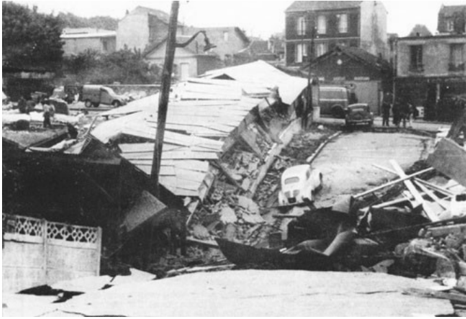
photo 5: Conséquences de l'effondrement généralisé de carrières de craie et de calcaire grossier à Clamart (92) en 1961 État des infrastructures routières et du bâti au droit des zones effondrées Origine des photos : M. Toulemont (M.A.T.E)
