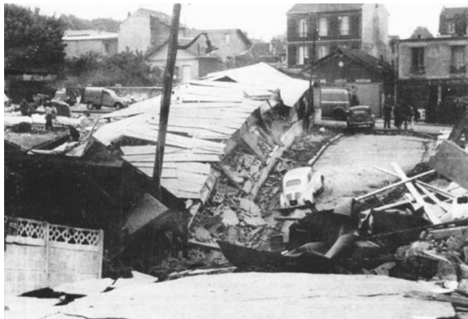
photo 27: Conséquences de l'effondrement généralisé de carrières de craie et de calcaire grossier à Clamart (92) en 1961 État des infrastructures routières et du bâti au droit des zones effondrées Origine des photos : M. Toulemont (M.A.T.E)
