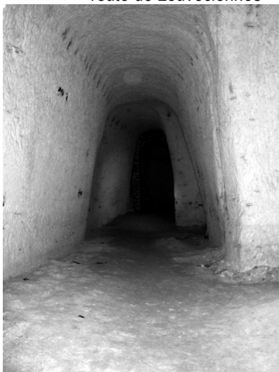
photo 16: Galerie dans la craie
