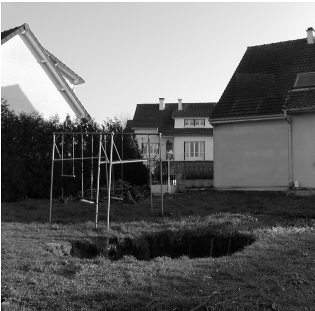
photo 26: Fontis venu à jour dans une zone pavillonnaire
