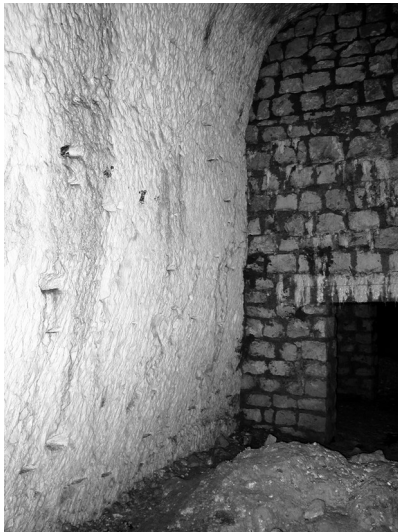
photo 14: vue d'un pilier et des consolidations sous le bâtiment 16 route de Louveciennes
