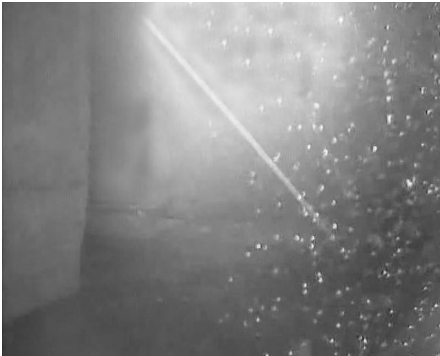
photo 20: Photo d'une galerie inondée
