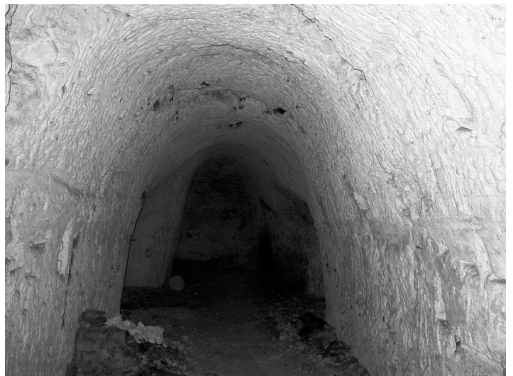
photo 17: Galerie dans la craie
