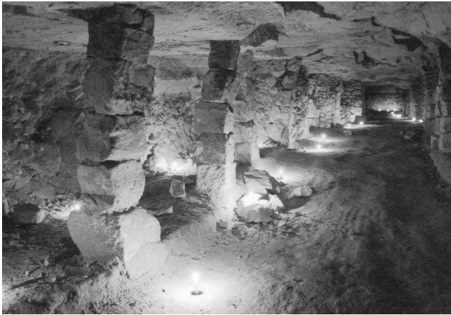
photo 4: Galerie avec piliers à bras
