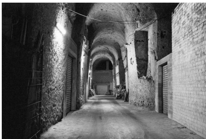
photo 18: galeries au niveau du 12 avenue de la Drionne
