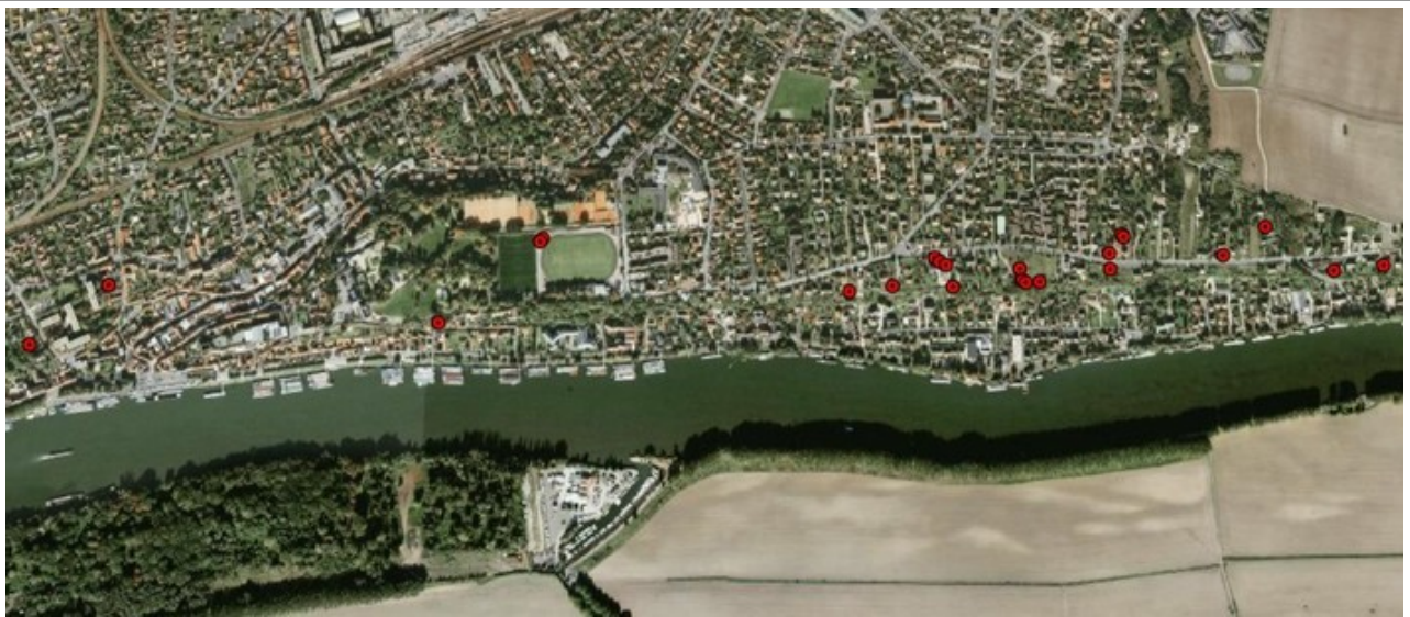
Figure 23 : Cartographie des désordres liés aux anciennes carrières souterraines survenus dans la commune de Conflans-Sainte-Honorine (image de fond : GoogleEarth)
