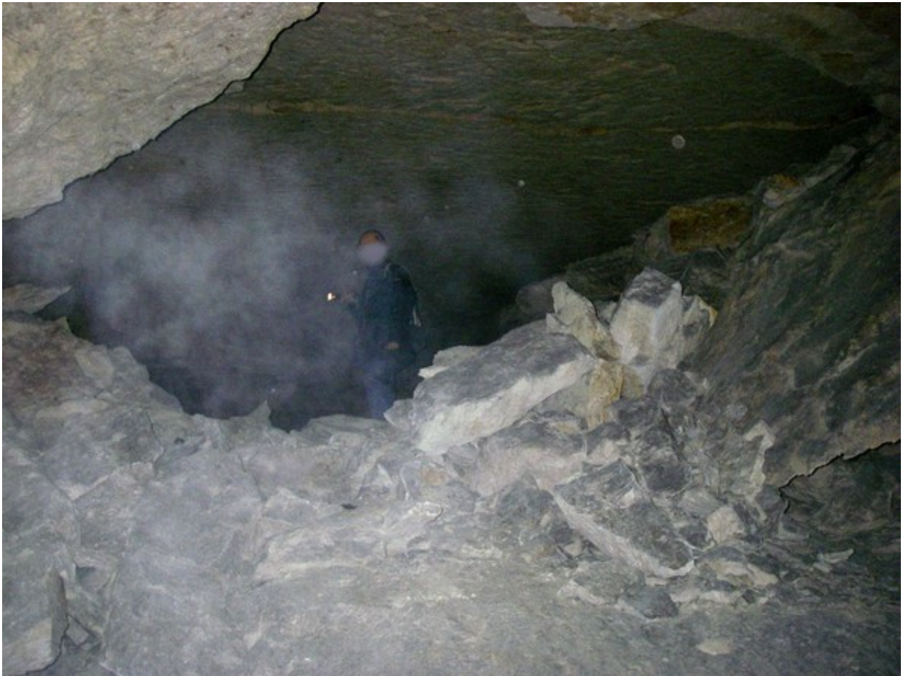
Photo 11 : Exemple d'un ciel tombé situé dans une des carrières de Conflans
