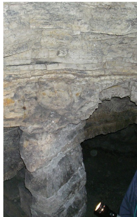
Photo 6 : Exemple de cave dans les Marnes et Caillasses
