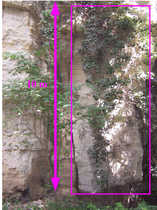
Photo 17 : exemple de masse – Résidence Chantoiseau (source: CETE IdF)
