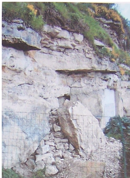
Photo 18 : photo de l'effondrement du front de la Sente des Laveuses dans une parcelle limitrophe (source: archives de la mairie)
