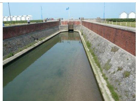
Exutoire en mer de la Scie (vanne)
