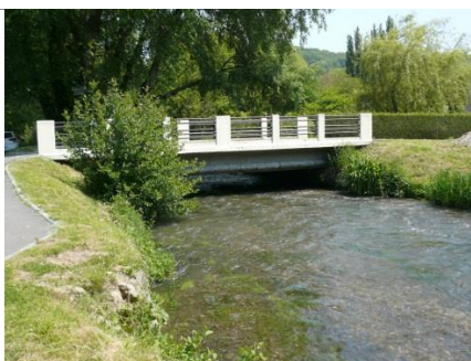
Traversée routière sur la Scie
