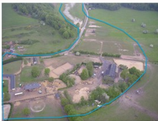
Crue de Mai 2000 (cliché DREAL)
