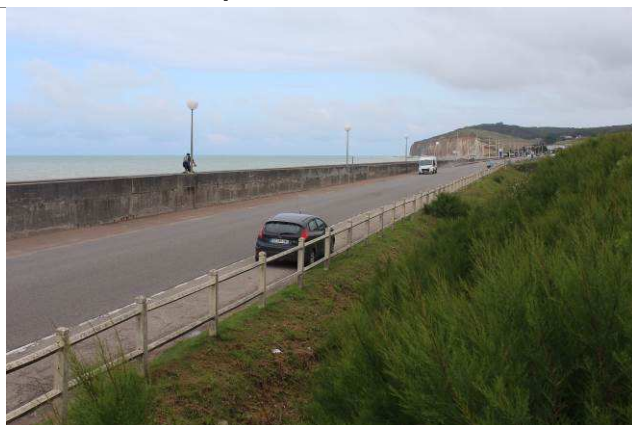
Digue au niveau de la promenade
