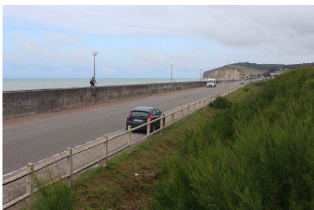
Digue au niveau de la promenade
