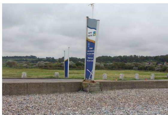
A l'Est de l'épi buse de la Saône au droit de la digue route
