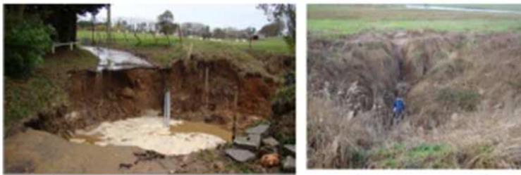
Photographie 2 - Doline bétaire (source : BRGM)
