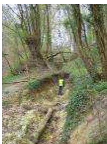
Photographie 7 : Chemin en cavée raviné par du ruissellement torrentiel
