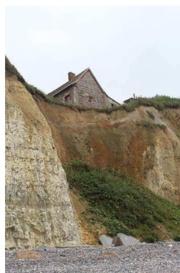
Erosion menaçant des habitations à l'Ouest de la plage
