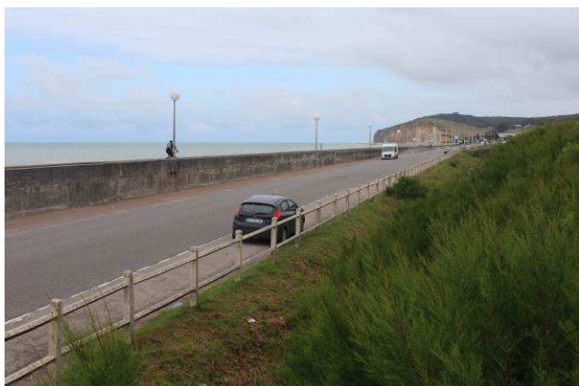
Digue au niveau de la promenade
