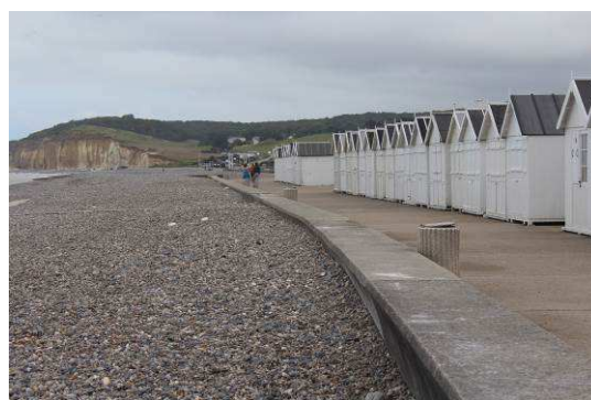
Fort engraissement retenu par les parapets
