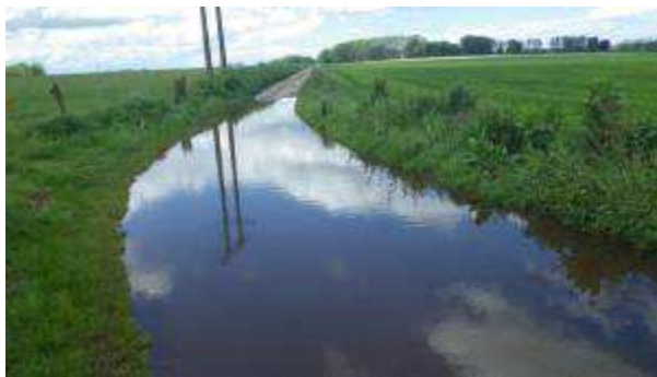
Photographie 8 - Inondation par stagnation d'eau dans une voirie
