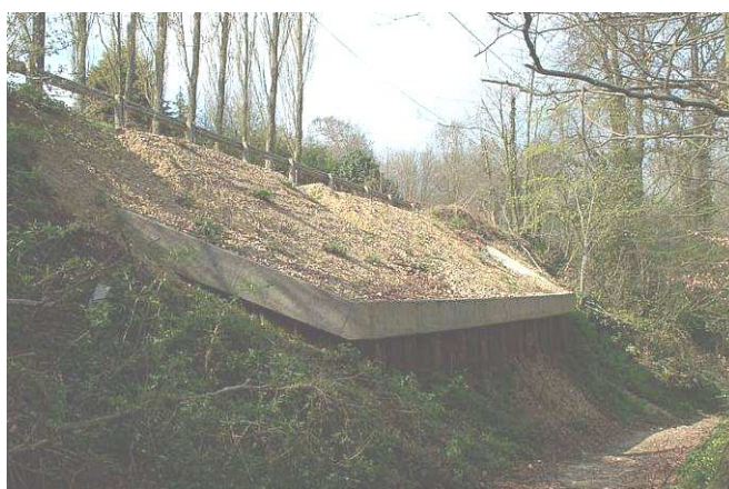
Photo 10 : Soutènement de la RD 4 à la Gaillarde
