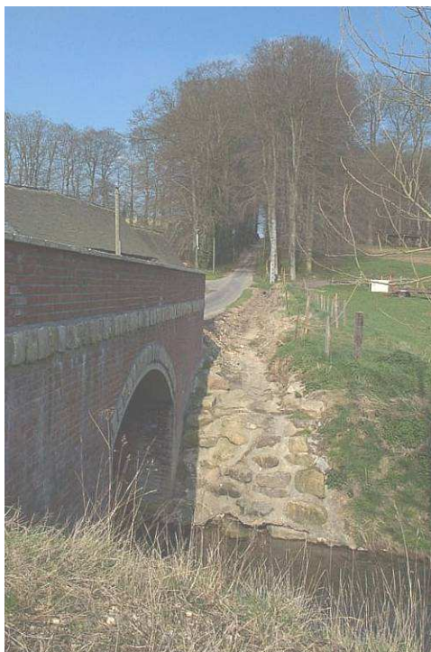
Photo 11 : Pont refait à la Gaillarde
