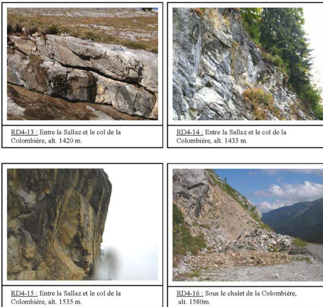
Figure 10ter : Ouvrages de protection sur la route départementale 4 (suite et fin)
