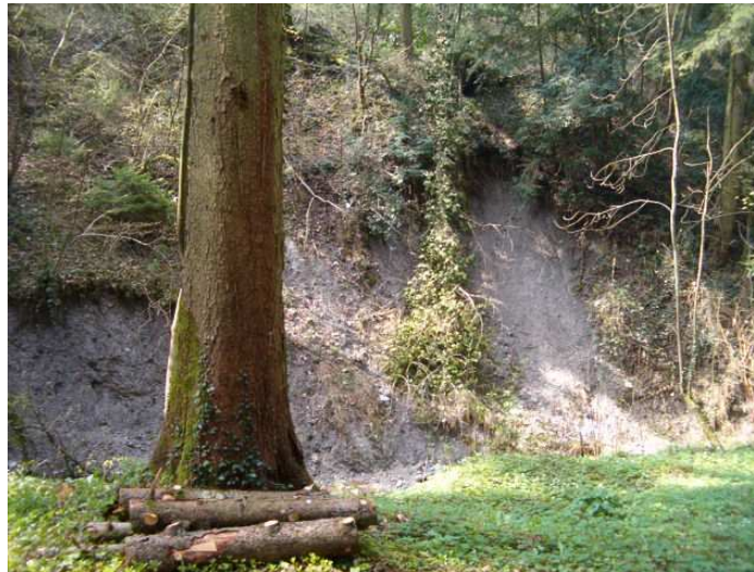
Photo 3 : glissement de terrain à "LA PLANTE"
