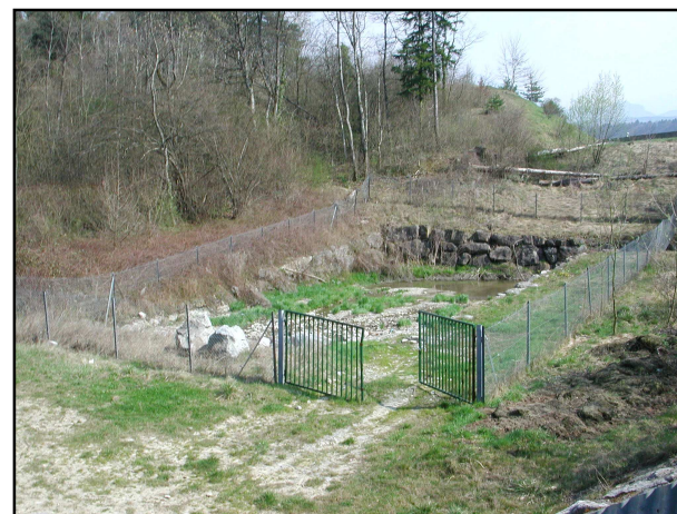
Cet ouvrage est situé sur la commune de Lucinge mais protège la commune de Cranves-Sales
