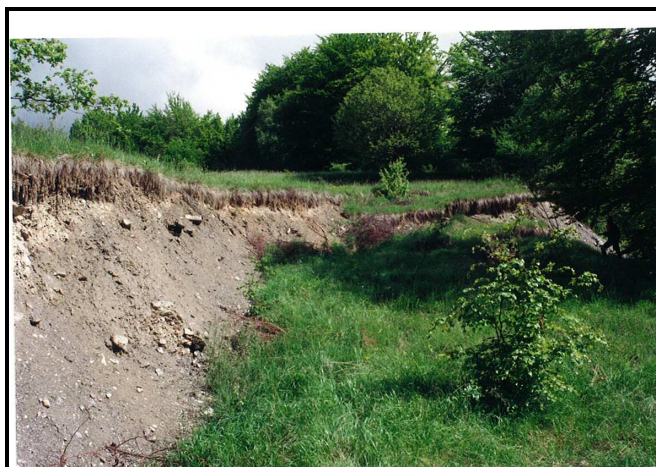
Photo 7 : Glissement des Pénys Cliché RTM 1996
