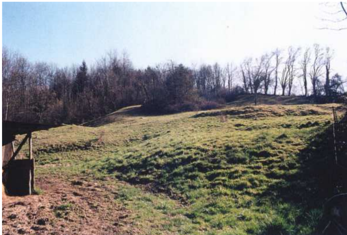
Commune d'ARCHAMPS : Instabilités au-dessus de Blécheins.
