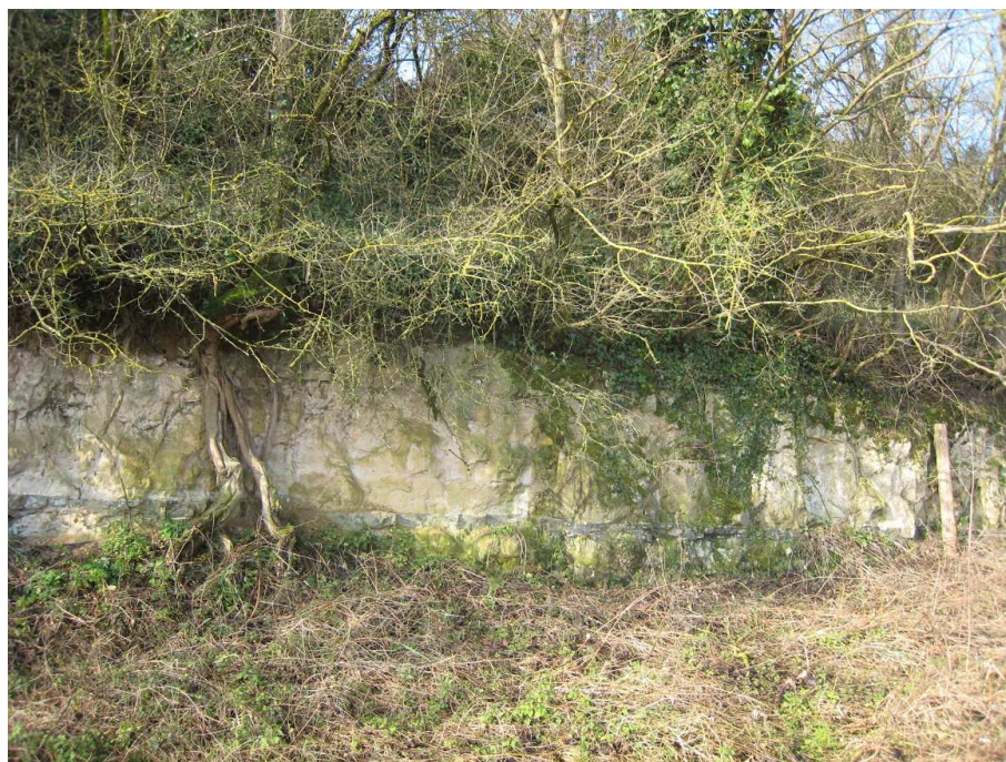
Figure 16 : Arbre en porte à faux – Parc sur Sarthe
