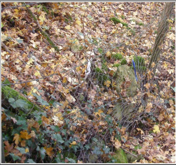
Figure 9 : Grillage déformé sous l'impact de pierres et de blocs
