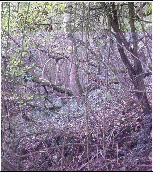
Figure 8 : Versant instable - Parcé-sur-Sarthe
