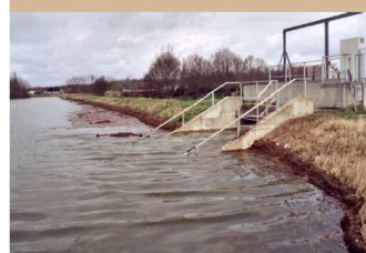
La digue d'Ouroux-sur-Saône (71)
