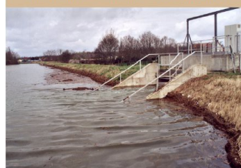
La digue d'Ouroux-sur-Saône (71)
