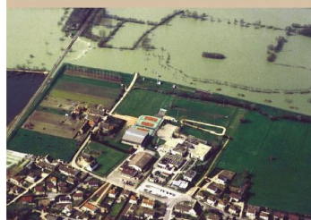
La digue de Saint Marcel (71)
