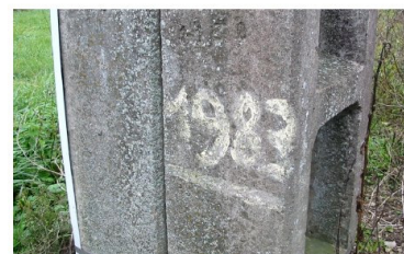
Repère de crue de 1983 à Gray-la-Ville (70)
