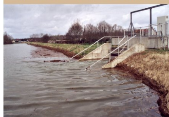
La digue d'Ouroux-sur-Saône (71)
