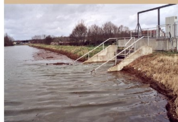
La digue d'Ouroux-sur-Saône (71)
