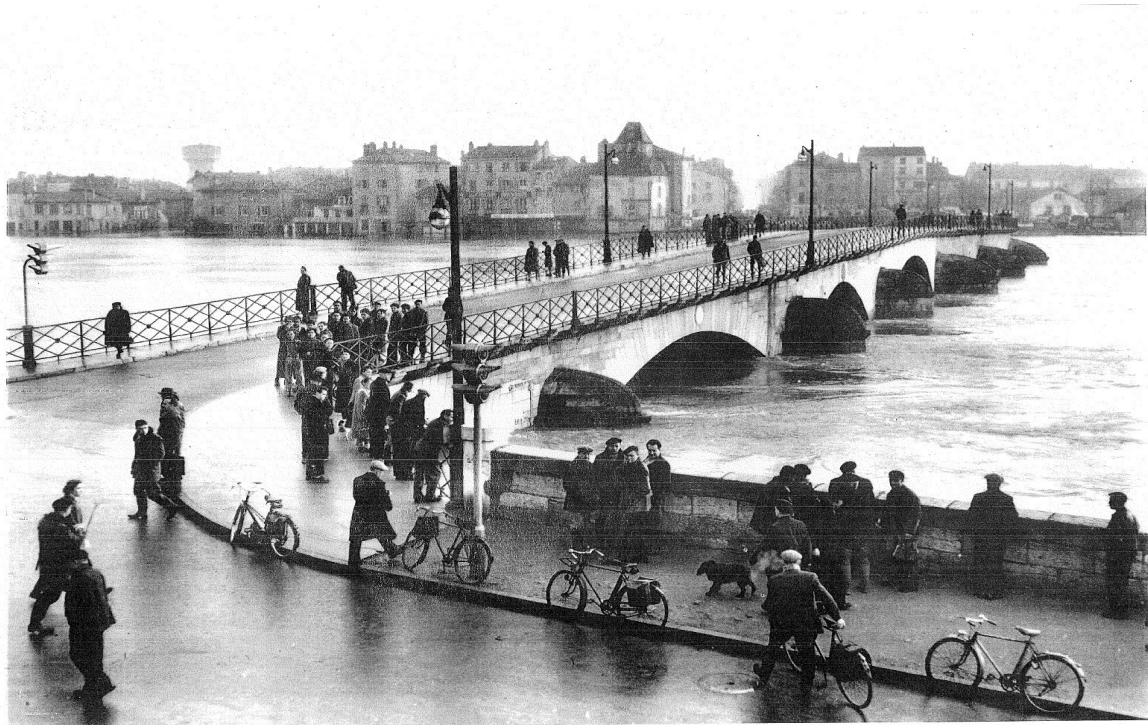
Mâcon, pont Saint-Laurent, crue de 1955
