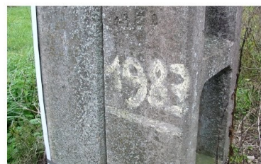
Repère de crue de 1983 à Gray-la-Ville (70)
