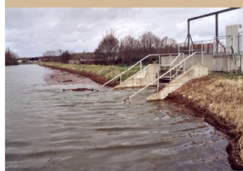
La digue d'Ouroux-sur-Saône (71)
