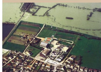
La digue de Saint Marcel (71)
