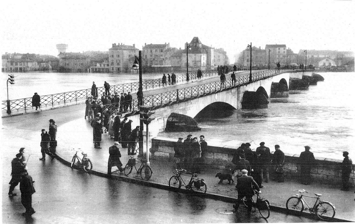
Mâcon, Pont Saint-Laurent, crue de 1955
