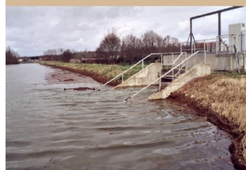
La digue d'Ouroux-sur-Saône (71)
