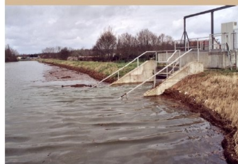
La digue d'Ouroux-sur-Saône (71)
