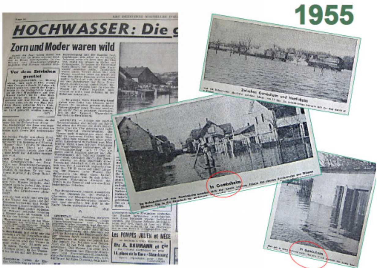
Figure 11 : inondations de 1955 sur le secteur de la Zorn et de la Moder. Sources DINA de janvier 1955
