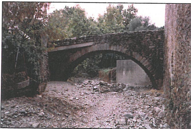
Le pont du ravin du Routès, avant sa confluence en rive gauche avec la Castellane, quelques mètres en amont de la passerelle.
