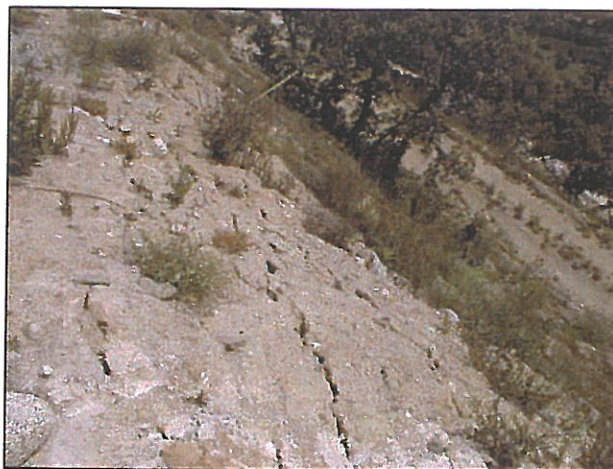
Figure n°7 : Aggravation par la sécheresse de désordres affectant un remblai argileux
