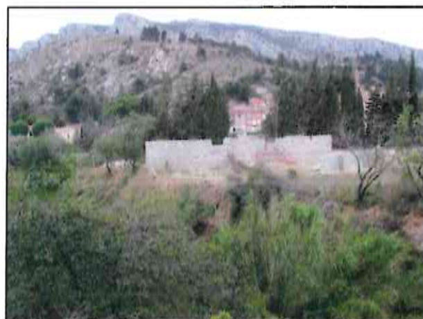
Ravin de la Millère : habitation en cours de construction directe sur la berge rive gauche !
