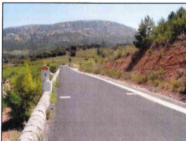
RD12 : Après travaux. Le dispositif de soutènement est complété par une cunette de pied de versant collectant les eaux pluviales.
