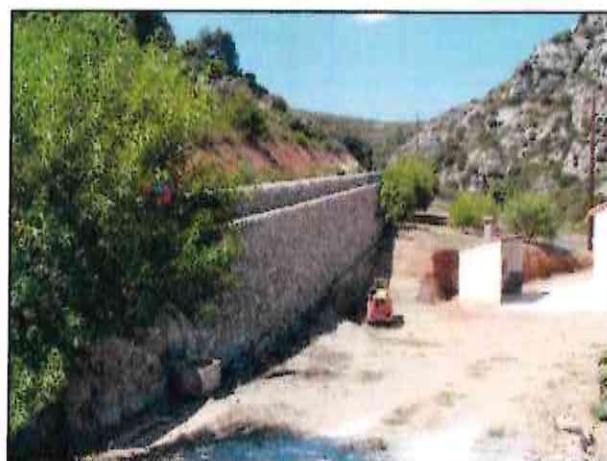
RD12 : Après travaux. Le dispositif de soutènement est complété par une cunette de pied de versant collectant les eaux pluviales.
