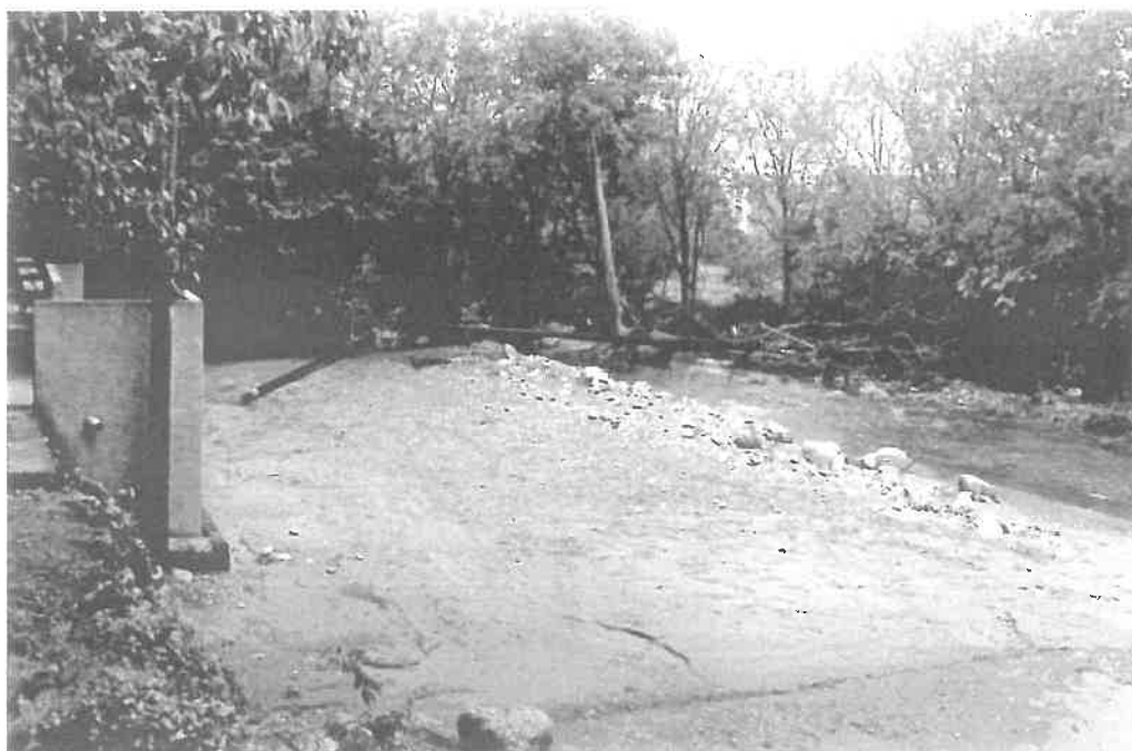
05. Le boulodrome municipal, situé en aval du pont du village a disparu, les terrains sont ravinés et les installations ont été emportées.
