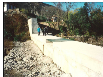
▲ Barrage aménagé en ouvrage RTM (décembre 1990)
