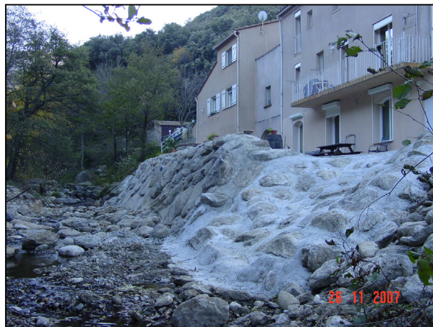
▲ Travaux de confortement des berges de 2007 en vallée heureuse.
