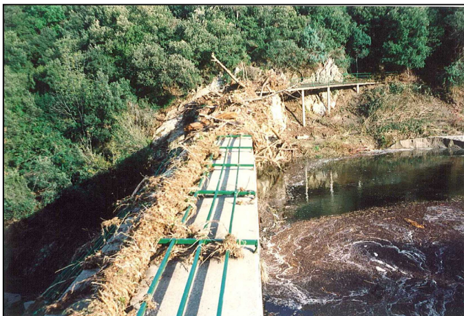
◀ Embâcle sur le barrage de la Fargue suite à la crue du 17 novembre 1989
