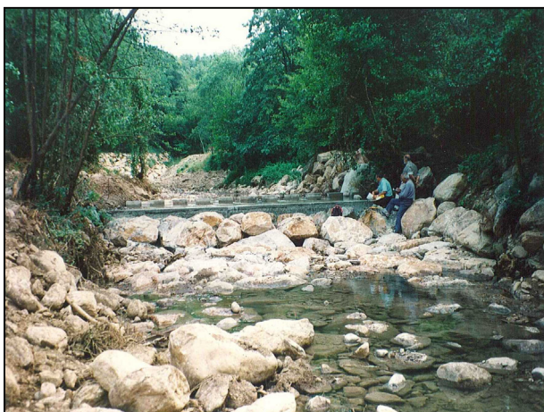
▲ Travaux de protection de la conduite d'eau potable avec passage à gué pour piétons, réalisés en mai 1997.
