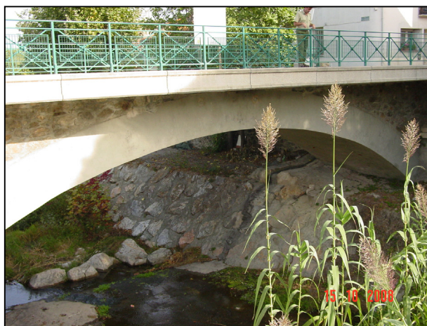
◀ Pont de la RD 2.
