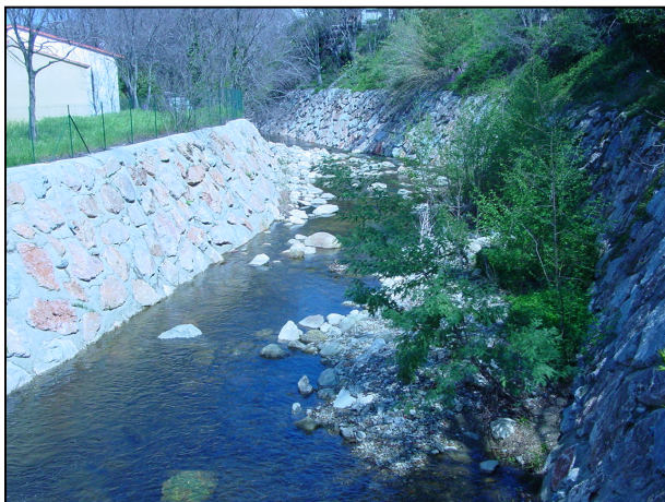
▲ Travaux de confortement des berges de 1997.
