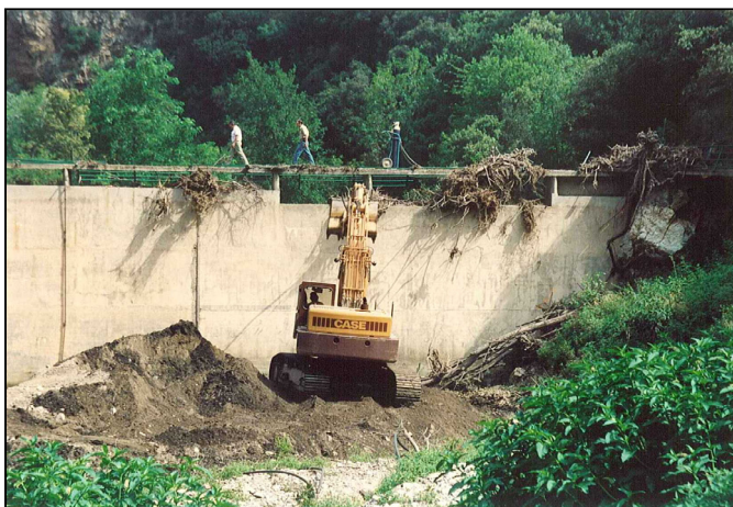
◀ Mise en place du chantier du Barrage de la Fargue en juin-juillet 1990 : nettoyage et démolition partielle de la cuvette
