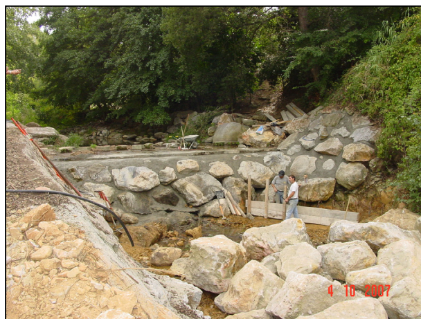
▲ Travaux de confortement 2007 au même endroit. Noter la différence de profondeur du lit.
