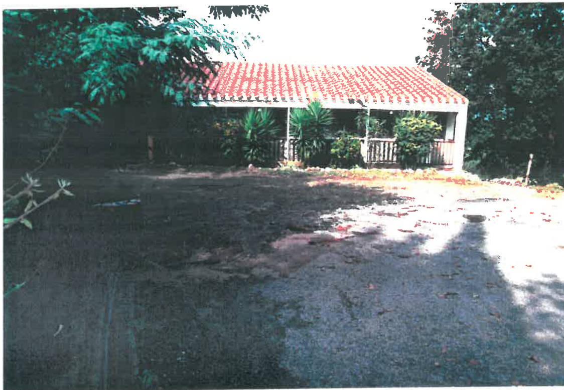
Domaine des Albères après un orage, au premier plan les avaloirs sont obstrués par de la terre et des débris végétaux. Déstabilisant un container les ruissellements ont raviné le bas côté de la route et les terrains en contrebas avant de rejoindre le ravin de Durbon.
