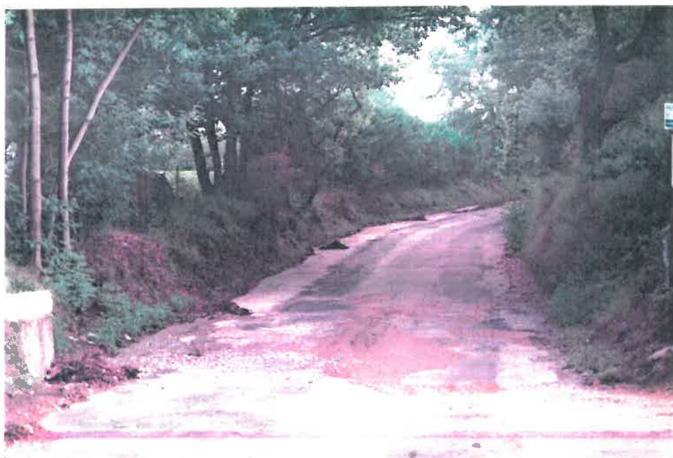
Le chemin de la Montagne après un orage. Chaque accumulation de végétaux correspond à une grille avaloir. L'émissaire a débordé en amont de sa canalisation souterraine (buse obstruée) puis a ruisselé sur la voirie jusque dans le lotissement de la Citadelle.
