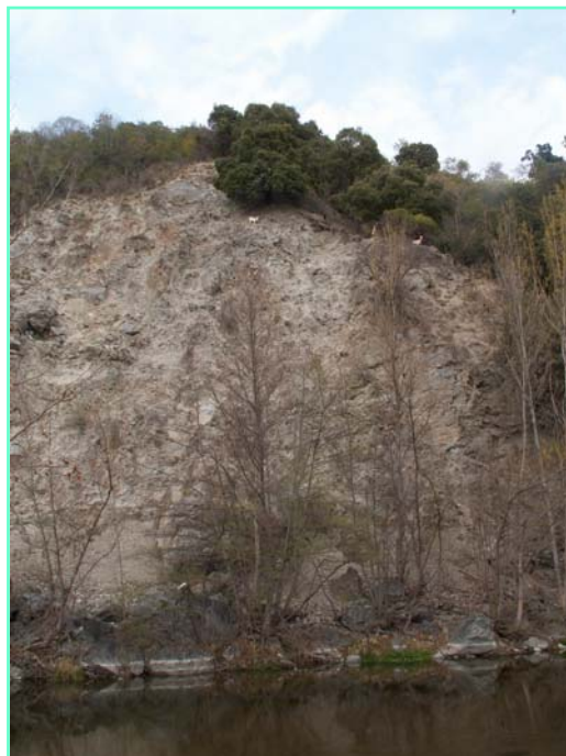
↑ Glissement de terrain au lieu-dit Rivesaltes en rive gauche du Tech à l'amont du Pont du Diable concernant un linéaire d'environ 300 m
