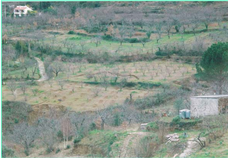
↶ Vue globale du Glissement de terrain des Castanyèdes en 1996 en coup de cuillère. On distingue bien à l'amont la niche d'arrachement dans les vergers et la zone d'effondrement à l'aval.
