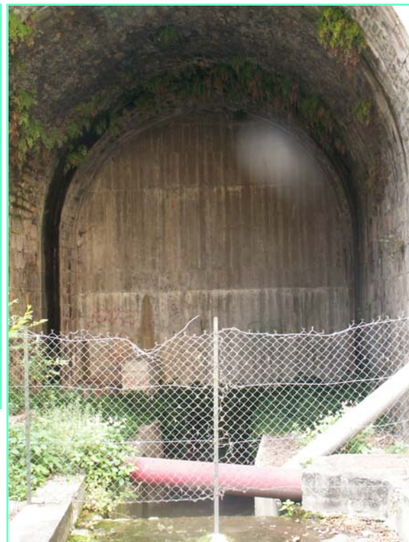
① Chenal busé à l'aval et en contre-bas du parking qui traverse une zone d'habitat dense ancienne.
