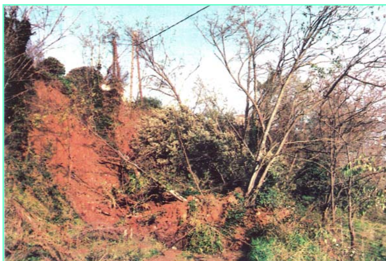
← Affaissement au lieu-dit La Foulcade en décembre 1987.
