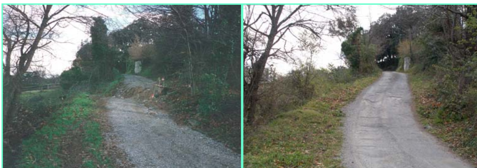
⬇ A gauche, affaissement en 1996 de la voie d'accès sur environ 1 m. A droite, même endroit aujourd'hui.
