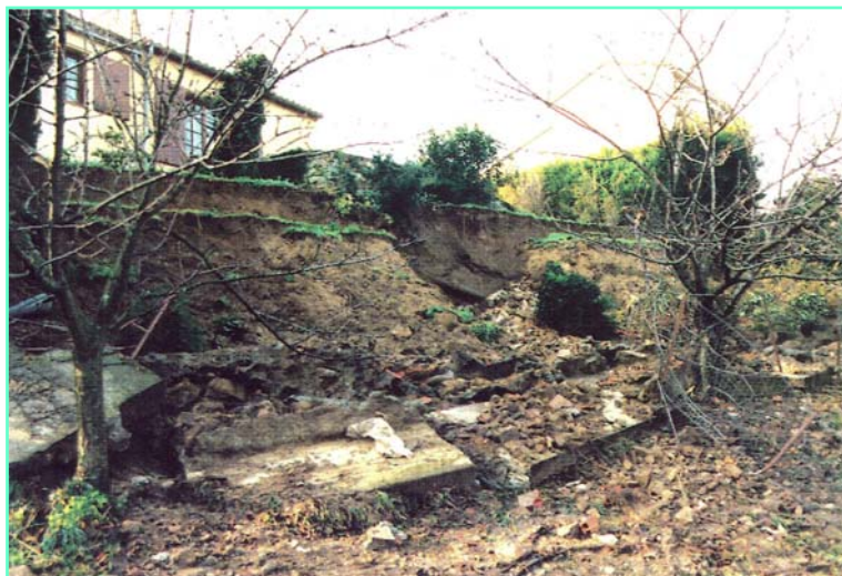
← Affaissement au lieu-dit Le Casteillas en décembre 1987
