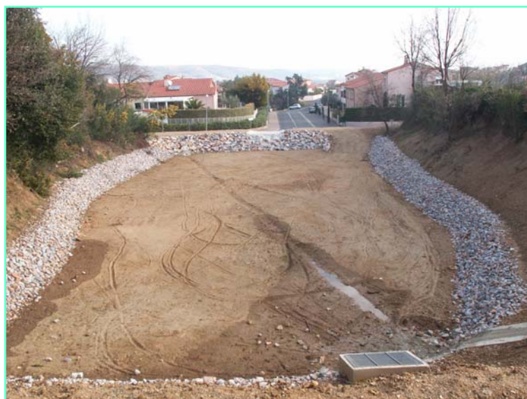
② Bassin de rétention aménagé avec surverse.
