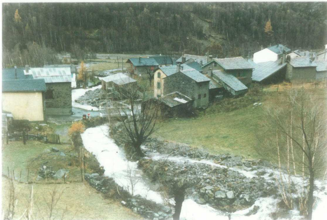
(Ph. 5. DDE Saillagouse). Photo prise depuis le pont de la RN 20. À l'aval du 1er pont du village, nouveau lit creusé par le torrent sur la voie communale.
