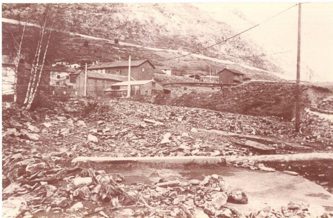
(Ph. 3 M. RIBES). Buse de la route du camping entièrement comblée par les matériaux. D'importants dépôts sont visibles, occupant le lit actuel du Cortal Roussou.
