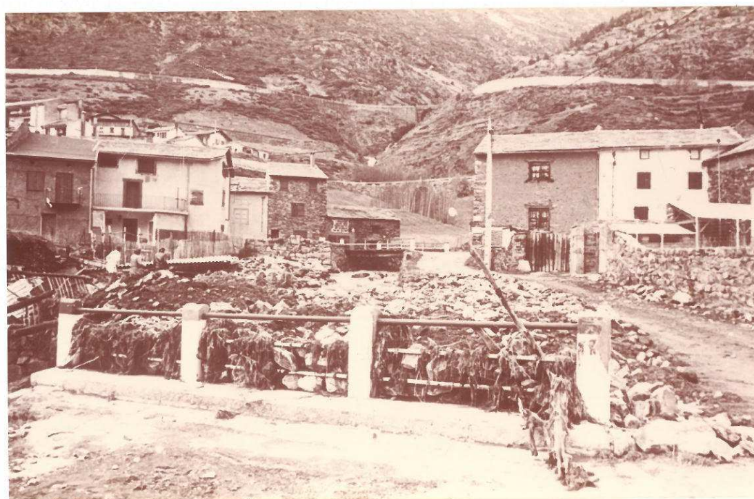
(Ph. 4 M. RIBES) 2° pont entièrement comblé de matériaux. L'embâcle ainsi créé a repoussé le torrent sur sa rive droite. Le 1er pont a été submergé par les eaux. A droite de la photo, au bord du ruisseau et de la voie communale, une maison a été reconstruite à l'emplacement même où une grange avait été emportée en 1902.
