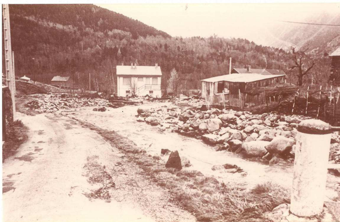
(Ph. 1 M. RIBES) Le 2° pont du village est comblé de matériaux. Le ruisseau a creusé un lit en rive droite, en empruntant la route communale.
