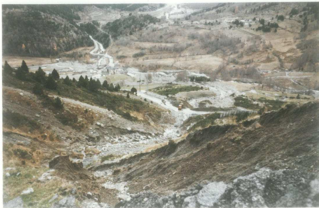
(Ph. 7. DDE Saillagouse). Vue d'ensemble du bas du ravin d'En Guillaume. Affouillement dans le chenal. Importants dépôts de matériaux à l'aval de la RN 20 qui a été coupée par la crue torrentielle.
