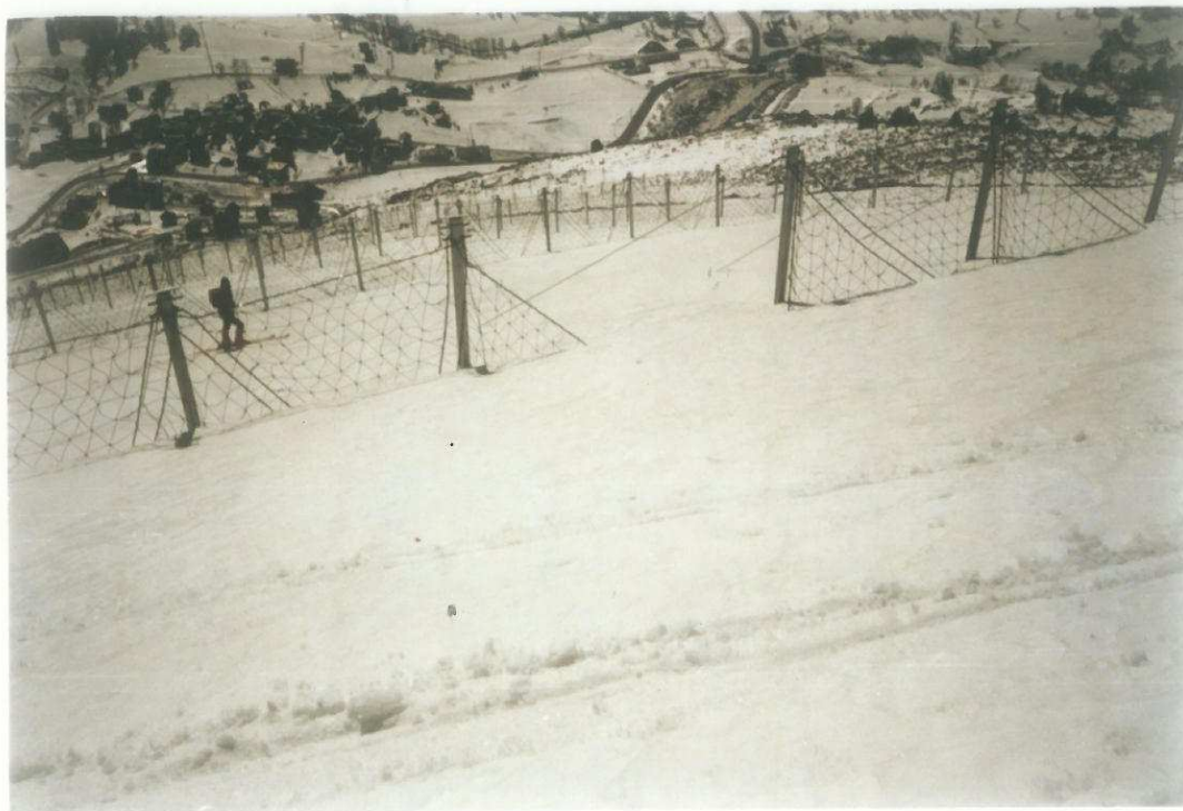
(Ph. 15. Service RTM. Hiver 87). Filets de protection du lotissement de la Douane. Les chalets sont visibles en haut à gauche de la photo.
