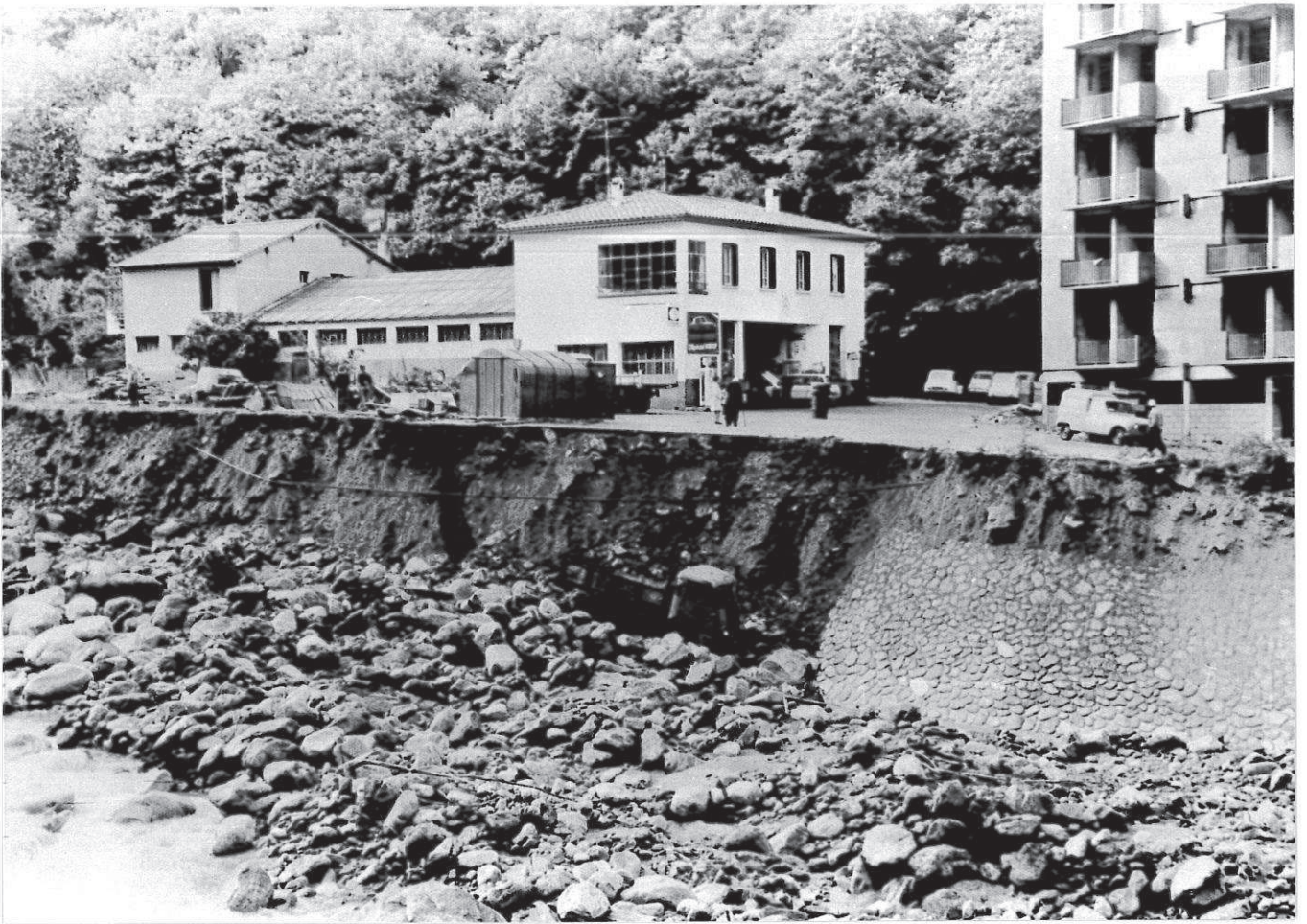
Parking de l'Établissement Thermal ( 1971 )
