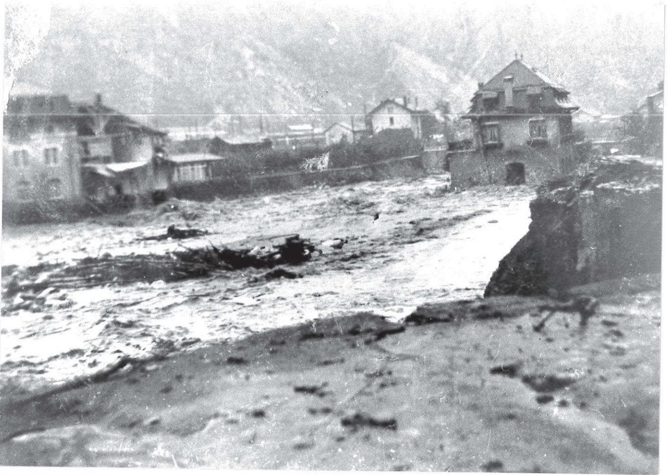
La Têt à VILLEFRANCHE DE CONFLENT en amont du confluent avec le Cady (1940)
