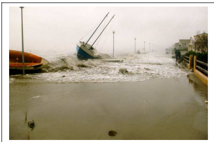
Passage d'une vague par-dessus un mur de front de plage à Port Leucate lors de la tempête de 1997. Le mur est à une altitude supérieure à 2m
