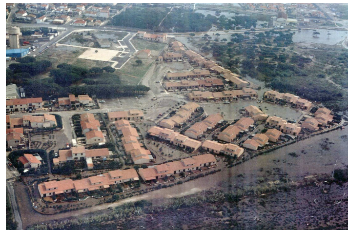
Le Barcarès, secteur des arènes, inondation du 13 octobre 1986
