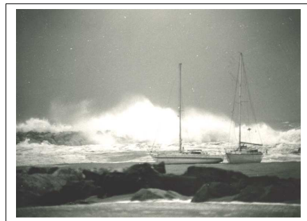
Franchissement d'un ouvrage de protection portuaire lors du déferlement des vagues.
