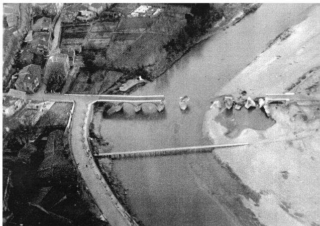
Le pont de Rivesaltes après la crue de 1940
