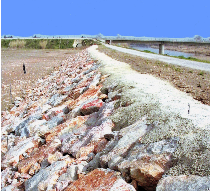
Enrochements posés sur la face aval des digues après la crue novembre 1999
